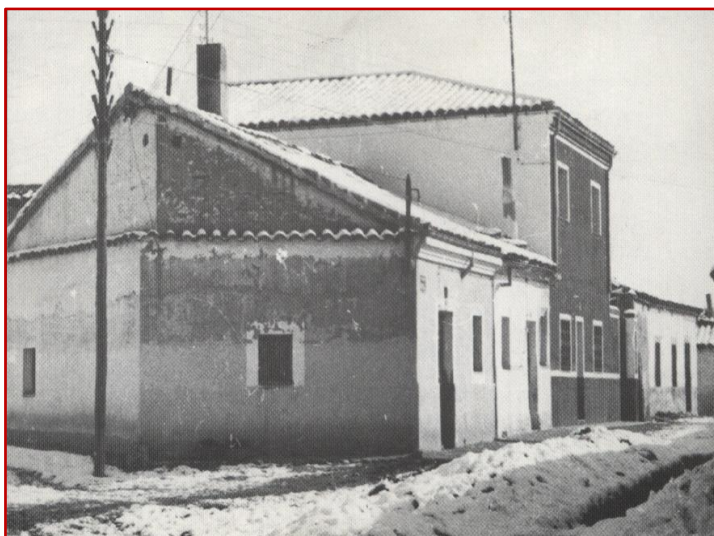
Intersección entre la calle Nápoles y la calle Madrid
