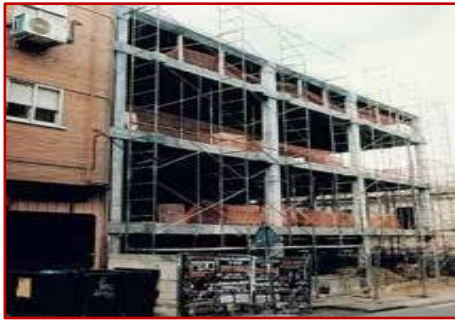
Edificio Juan Muñoz en construcción
