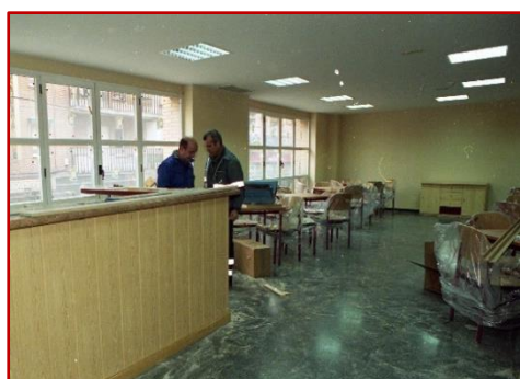
Operarios ultimando los últimos detalles en el interior
